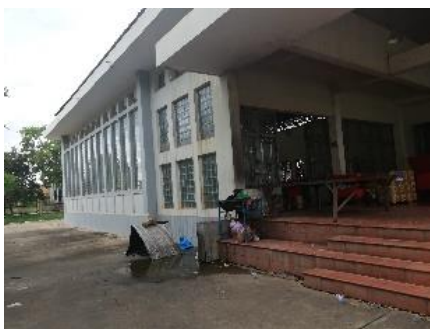
学生ホール入り口工事前 (2023年11月15日)
