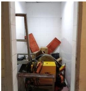
トイレ工事前 (2023年12月2日)
