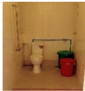
トイレ工事後 (2023年12月23日)
