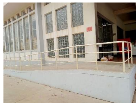
学生ホール入り口工事後 (2024年3月21日)
